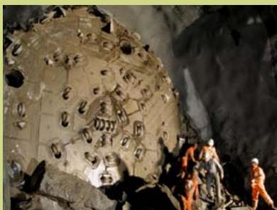
Les tunneliers de Steg et Rarogne sont deux tunneliers ouverts Herrenknecht pour roche dure dont les caractéristiques sont les suivantes :
