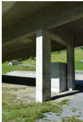
Pile courte côté Sud
